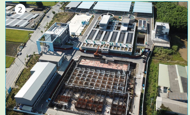
1. 石門水庫至新竹聯通管-道路埋設段工程 2. 曾文淨水場擴建工程第二期工程
