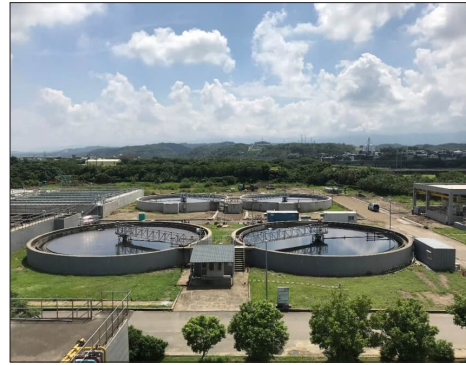
▲ 竹南頭份水資源回收中心(二沉池)
