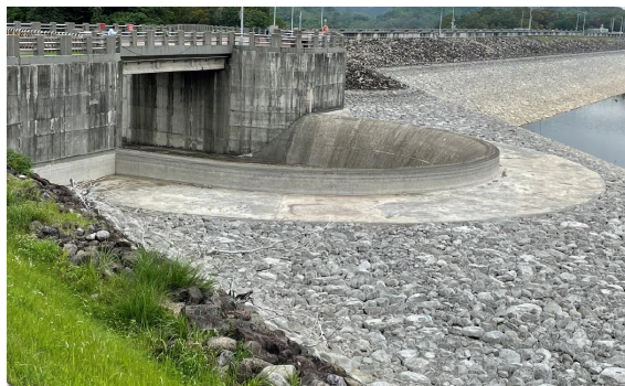
▲石門水庫至新竹聯通管-道路埋設段工程
