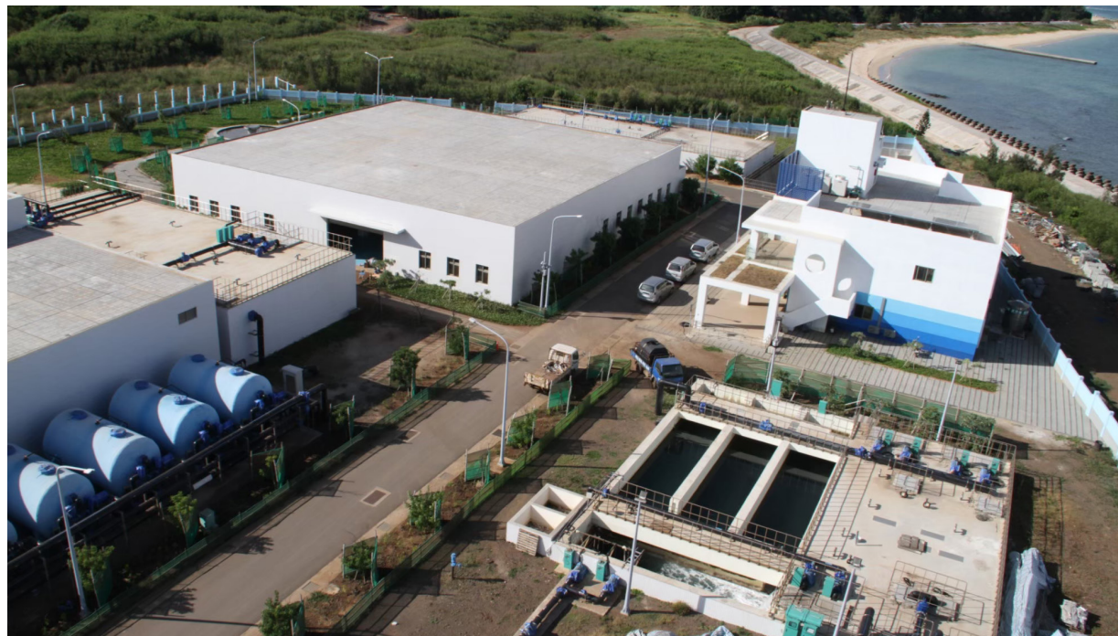
▲ 馬公海淡二廠4000CMD 海水淡化廠
