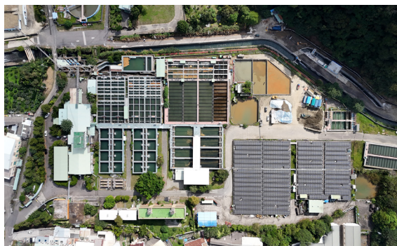
▲豐原一場一、二期淨水設施更新統包工程
