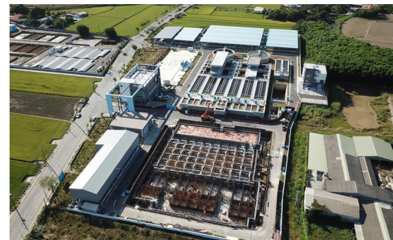
▲曾文淨水場擴建工程第二期工程
