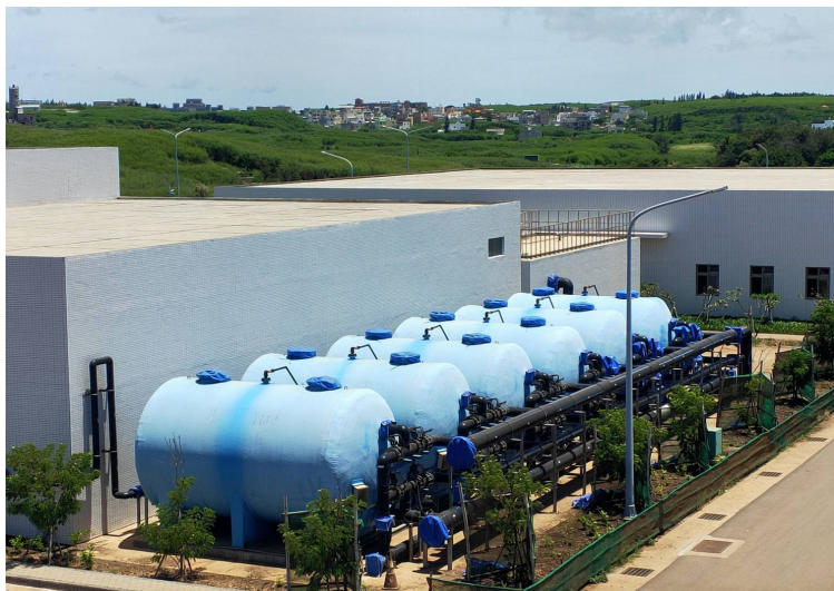
▲馬公增建4,000噸海水淡化廠（馬公第二海水淡化廠第一期） 新建工程暨委託代操作維護
