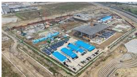
▲南科高雄第二(橋頭)園區污水處理廠一期新建工程
