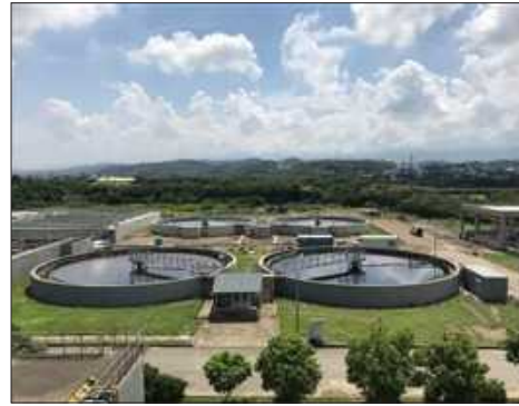
▲ 竹南頭份水資源回收中心(二沉池)
