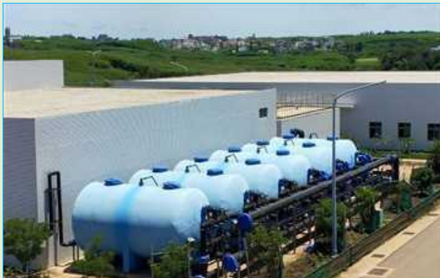
馬公增建4,000噸海水淡化廠 (馬公第二海水淡化廠第一期) 新建工程暨委託代操作維護
