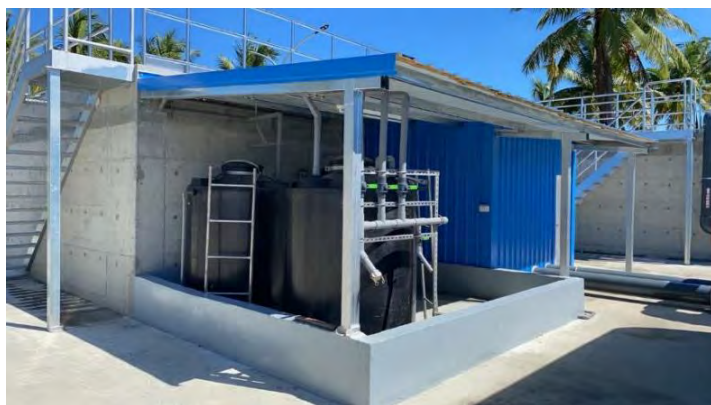
111 年林邊淨水場應急供水工程
