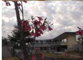
大金門 4000CMD 淡化廠已竣工完成。
